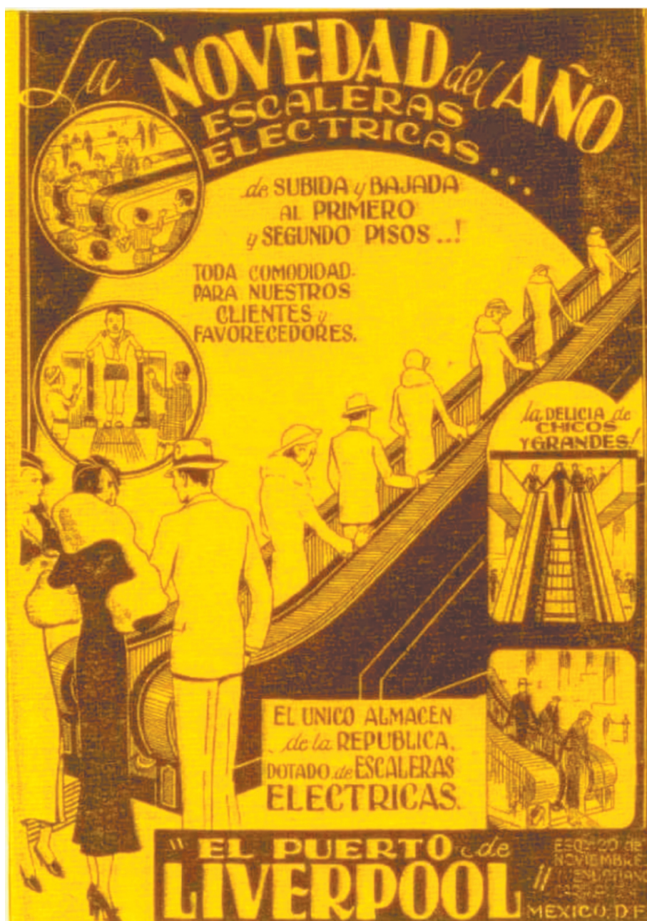
Escaleras eléctricas, como no se habían visto antes.
