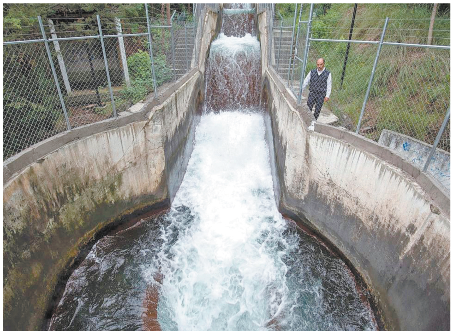
Uno de los canales del sistema Cutzamala.
