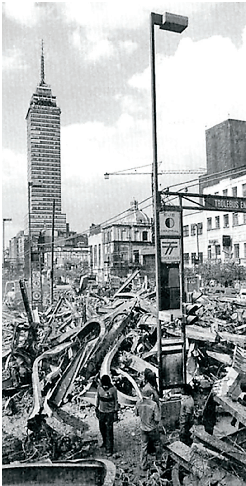
Vista del Eje Central luego del terremoto del 19 de septiembre de 1985 en la ciudad de México.
