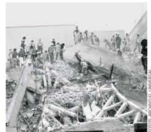
DERRUMBE Edificio colapsado en el centro de la capital del país
